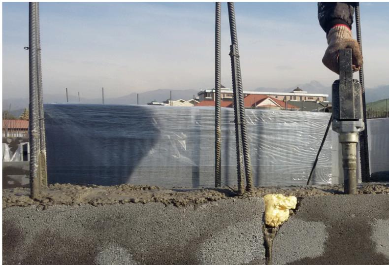
**Рисунок 17 – Уплотнение бетонной смеси глубинным вибратором**
