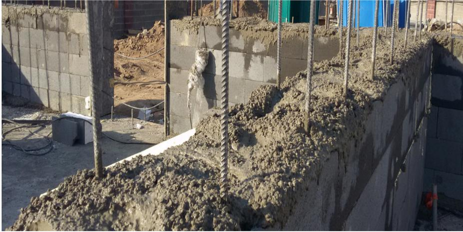
**Рисунок 16 – Фрагмент несущей стены до уплотнения**
