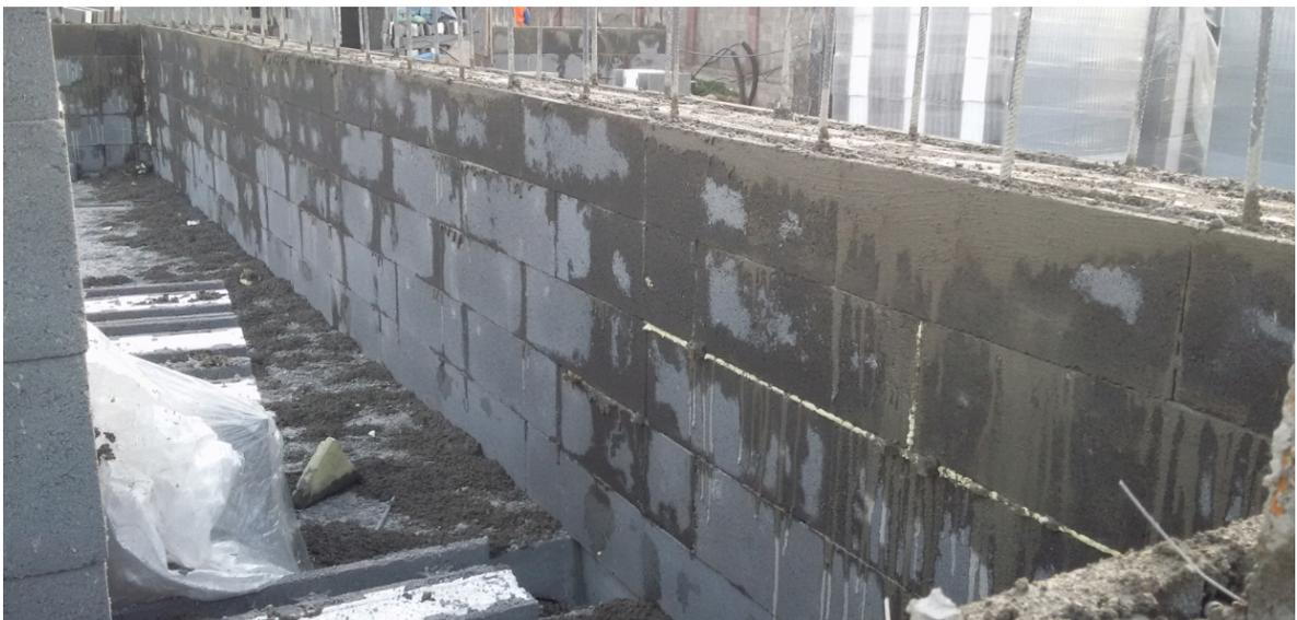
**Рисунок 18 – Фрагмент несущей стены после уплотнения**
