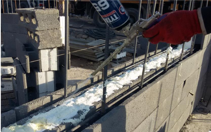
**Рисунок 12 – Нанесение полиуретановой пены на стеновые блоки**
