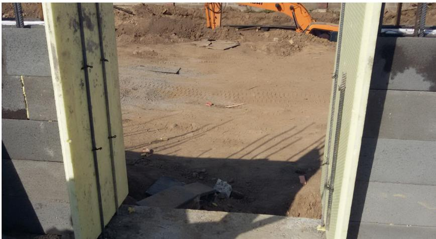
**Рисунок 14 – Торцы прстенков оконных и дверных проемов в опалубке для приема**
