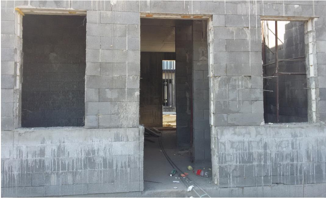
**Рисунок 21 – Общий вид проемов после распалубки**
