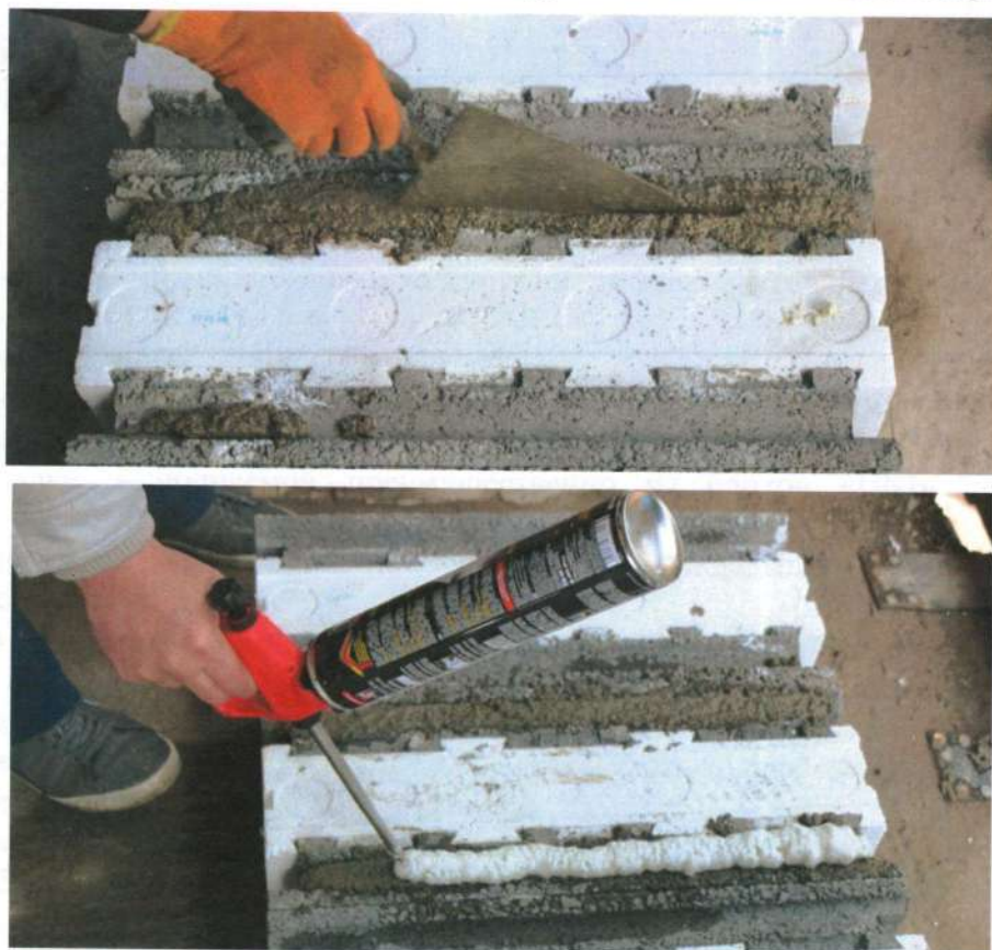
Рис. 3.2 Процесс заполнения горизонтальных пазов в блоках «UNI» цементно-песчаным раствором и, затем, горизонтальных швов между блоками клеем
